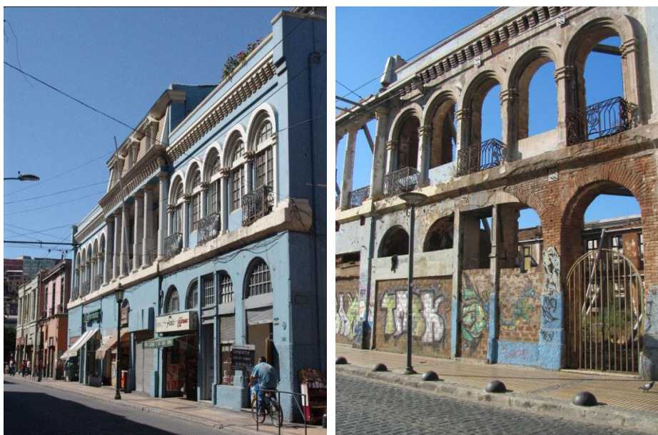
9. A la izquierda, edificio Subercaseaux previo al incendio 2007. Fuente: Dirección de Gestión Patrimonial. A la derecha fotografía 2013. Fuente: Archivo propio.
