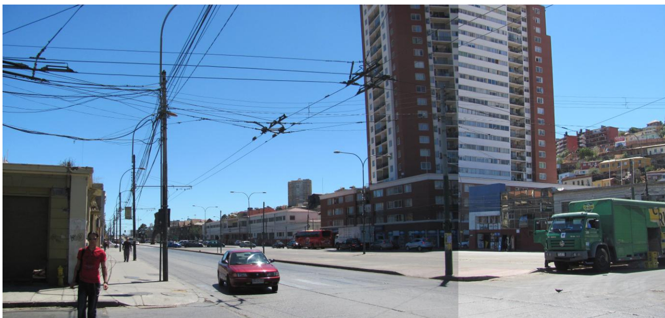
23. Edificación en altura, avenida Argentina (ZCH). Fuente: Archivo propio. Enero 2013.
