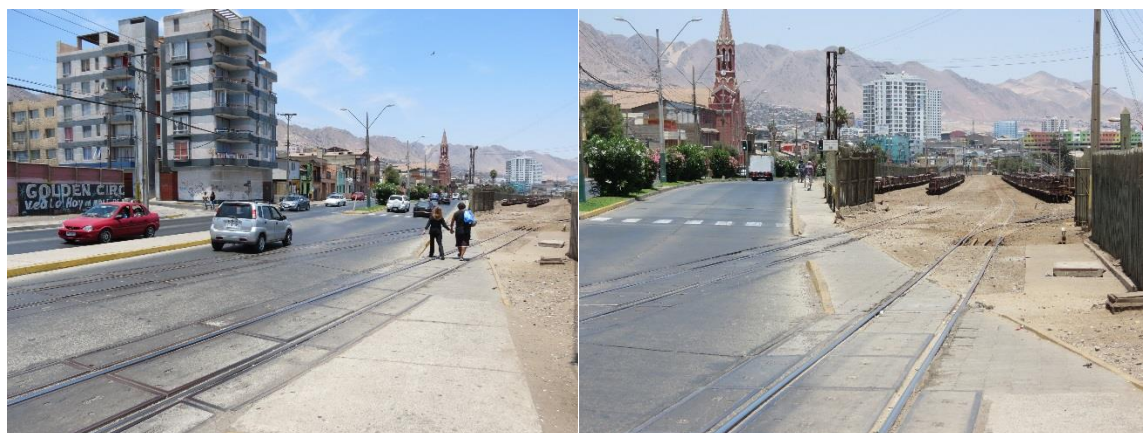
Figura 21: Cruce línea férrea por calle Iquique
