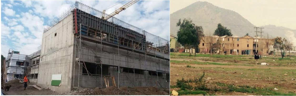
Imagen N° 13: Construcción Comisaría Bajos de Mena paralelo a demolición de Población El Volcán II
