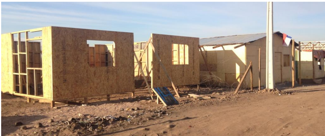
Figura 14. Proceso de construcción de las primeras casas en el campamento
