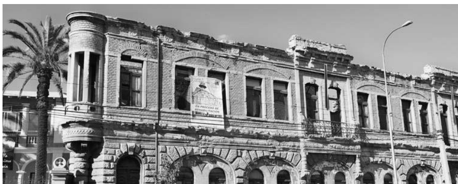
Imagen 20 Deterioro Cervecería Ebner, fotografía por Avenida Independencia, s/f.
