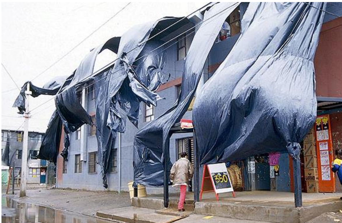
Ilustración 4: Casas "Copeva" cubiertas por nylon
