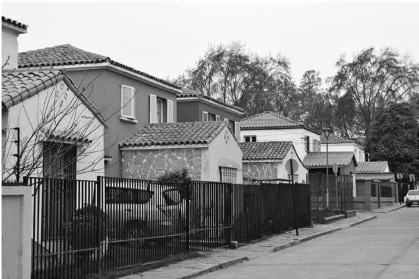
Caja de Retiro y Previsión Social de los FF.CC. del Estado. Conjunto para empleados de los FF.CC. de La Serena, 1949. Plano Archivo Dirección de Obras Municipales de La Serena, fotografía del autor, 2019.
