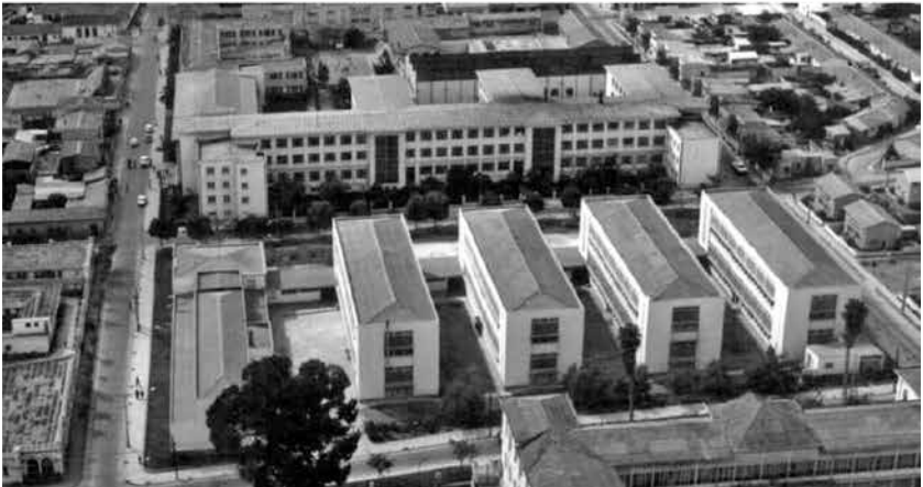
E. Gramegna Dirección de Arquitectura, MOP Escuela de Minas, 1952. Planimetría proyecto original. Archivo Dirección de Obras Municipales, fotografía Colección Museo Histórico Gabriel González Videla.
