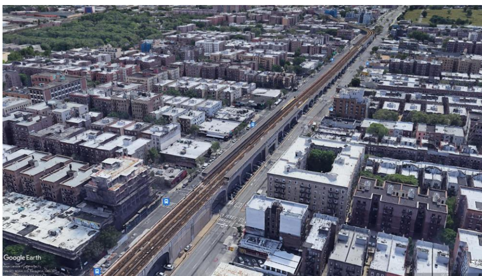
Figura 8. Flushing line (tren 7) en la actualidad en Queens, NY.
