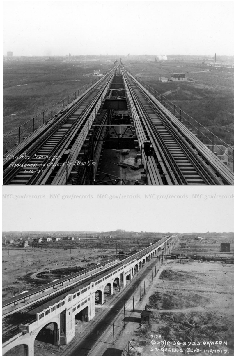
Figura 7. Flushing line (tren 7) durante su construcción en Queens, NY.
