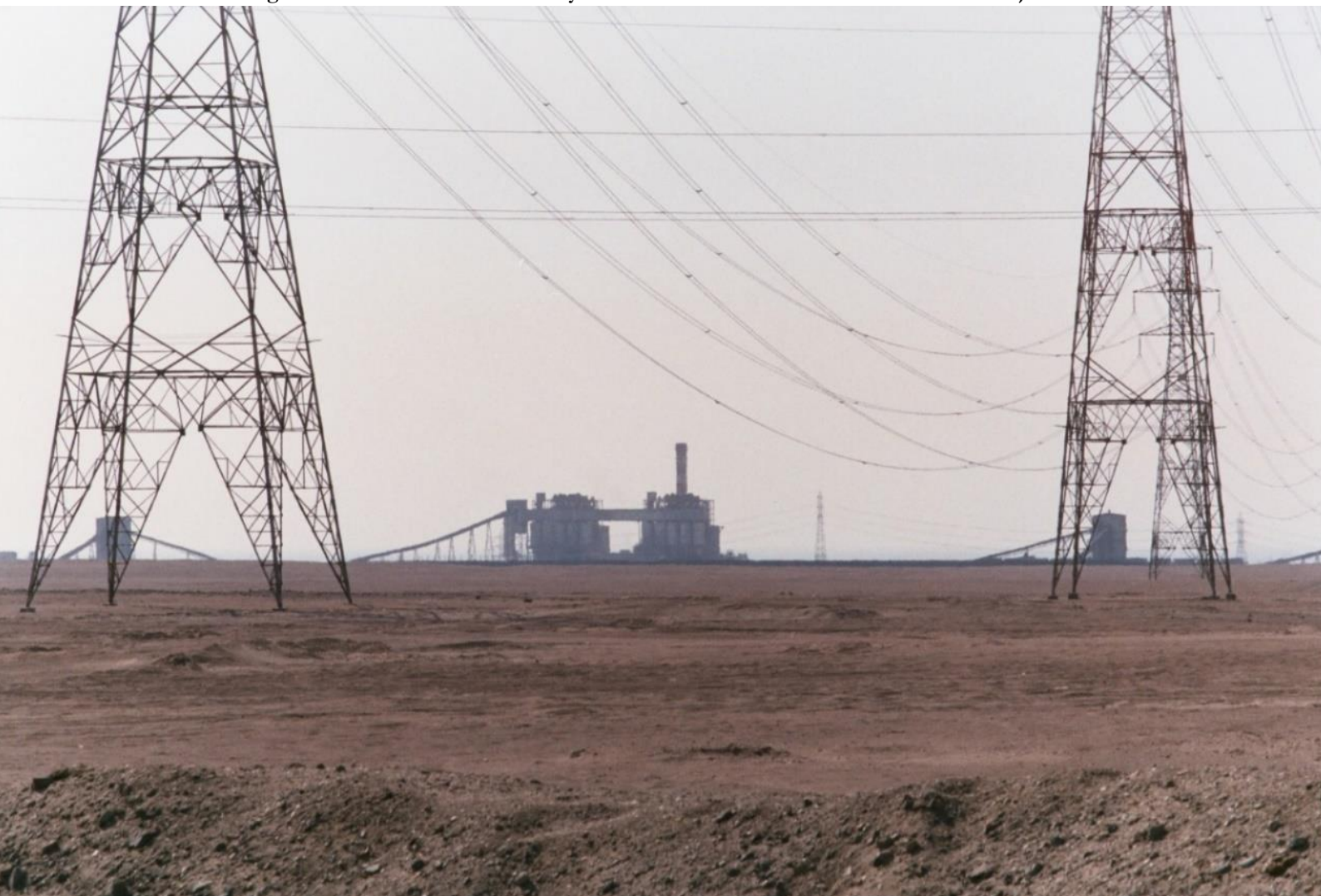
Imagen 2: unidades termoeléctricas y líneas de alta tensión desde el acceso sur a Mejillones.
