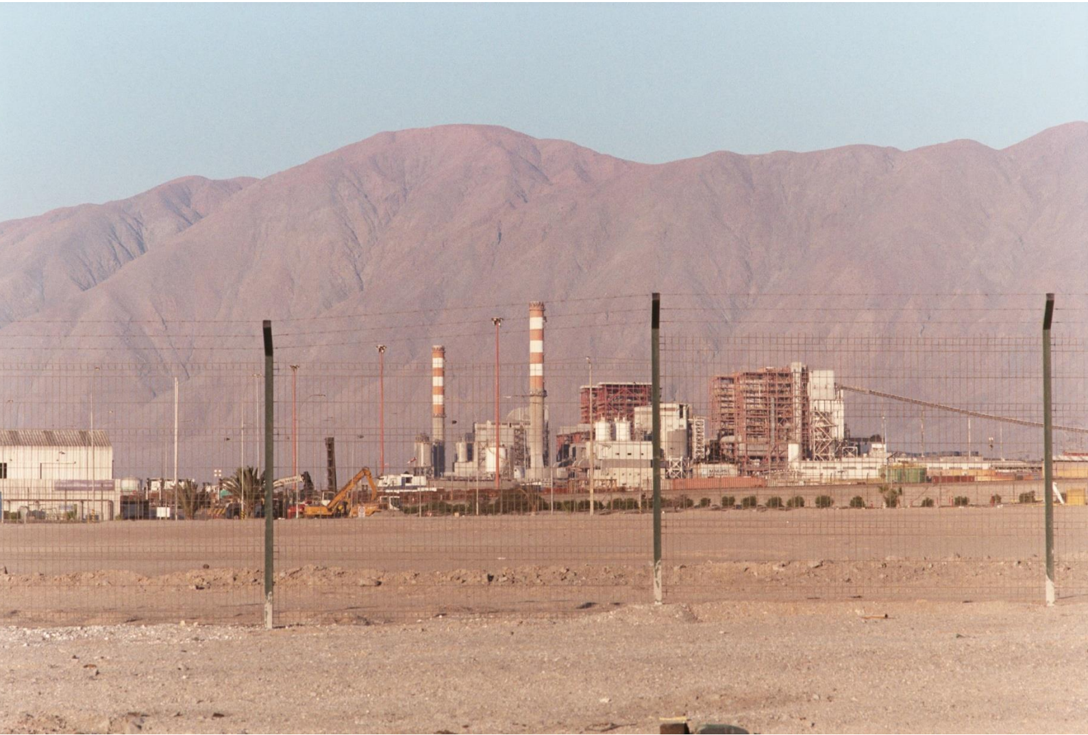
Imagen n°12: Centrales termoeléctricas Angamos y Cochrane desde el acceso al CPM.
