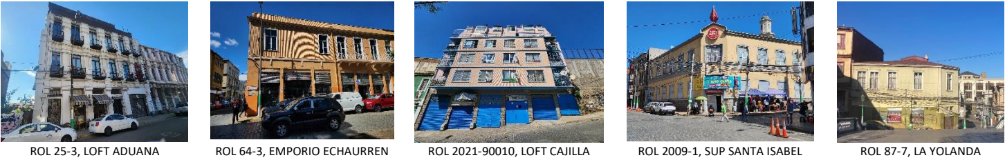
Imagen 26 Proyectos Ejecutados Barrio Puerto
