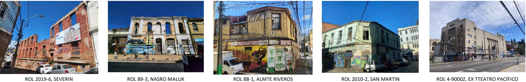
Imagen 21 Inmuebles abandonados/inhabitables Barrio Puerto
