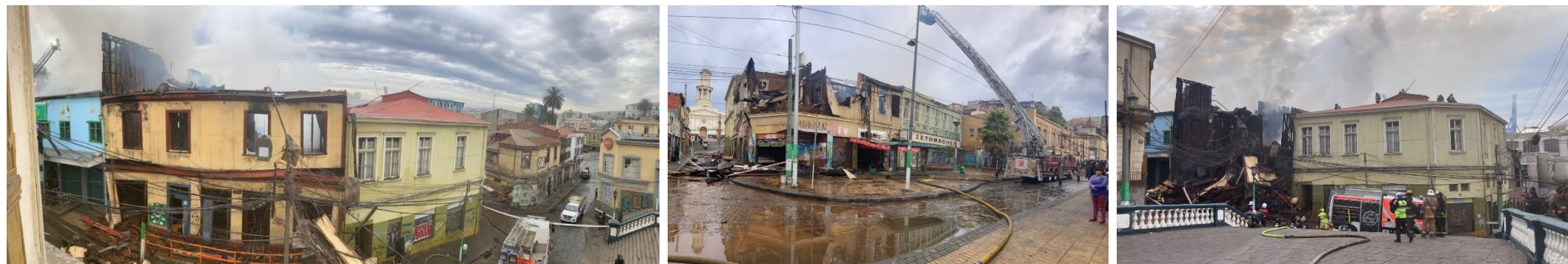
Imagen 75 Registro incendio que afectó 4 predios, entorno inmediato Iglesia la Matriz
