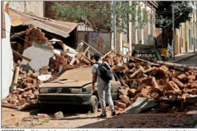
AFECTADOS.— El terremoto de una vivienda de tres pisos, ocurrido hace casi dos semanas en el sector de Torre Agia y la persona afectada.
