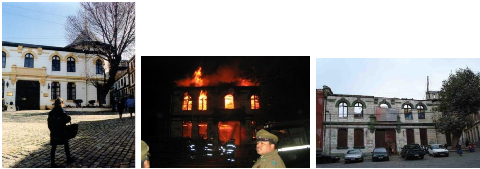
Imagen 23 Registro proceso deterioro ICH 2019-5, estado 2002, incendio 2006, estado 2024.
