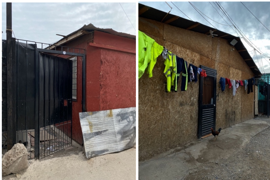
Figura 4. Fachadas de las viviendas en Nuevo Amanecer, 2024
