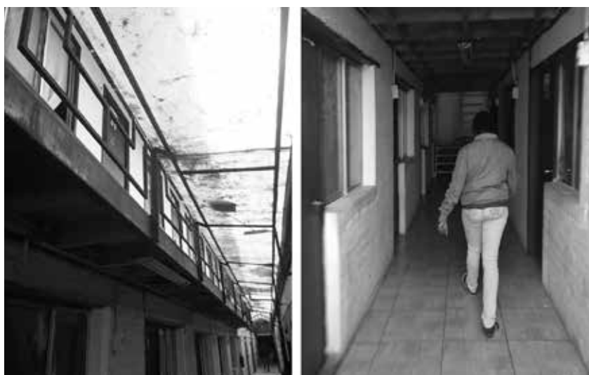
Figura 8. Fotografías pasillo principal y acceso a habitaciones. Fuente: Autora.
