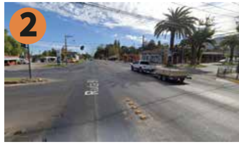
Cruce semaforizado en buen estado, se debe conectar con la futura red de veredas y ciclovías.
