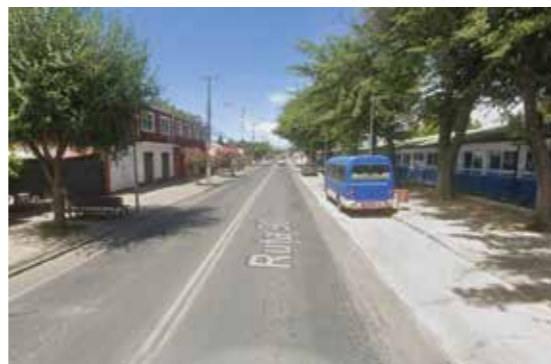
La ruta 90 en la zona urbana, con amplias veredas y paradas de bus.
